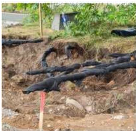
1.4.3 pav. Medžio šaknų nuo 5cm Ø aprišimas geotekstile.
