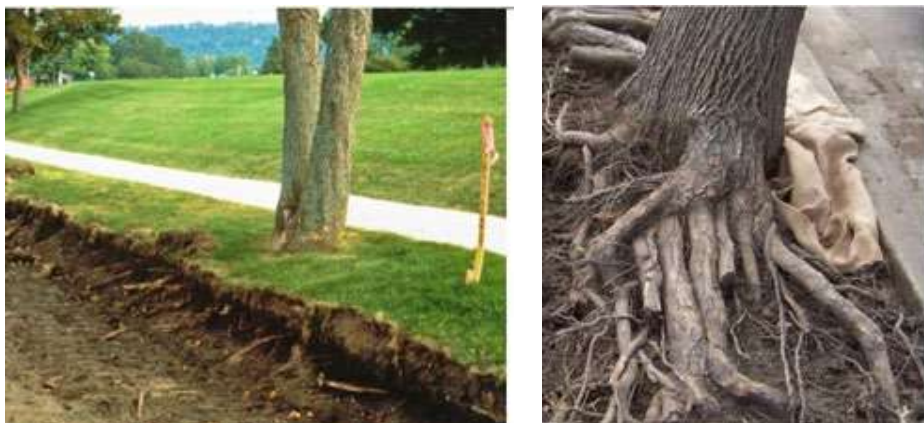
1.4.5 pav. Neigiami darbų pavyzdžiai - darbai atlikti netinkamai. Įrengiant iškasą, nutrauktos, nudraskytos šaknys.
