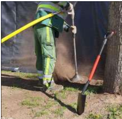
1.4.1 pav. Medžio šaknų atkasimas oro kastuvu.
