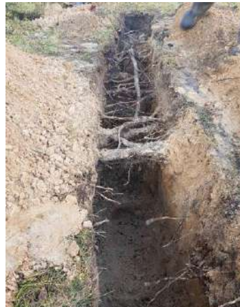
1.4.4 pav. Teigiami darbų pavyzdžiai - darbai atlikti teisingai, Medžio šaknų atkasimą oro kastuvu, taip išsaugomos smulkios ir medžiui svarbios šaknys, sudaromos sąlygos medžiui tarpai ir prisitaikyti prie pakitusių aplinkos sąlygų.
