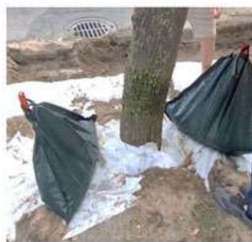
1.4.2 pav. Medžio šaknų dengimas geotekstile ir nuolatinio laistymo užtikrinimas.
