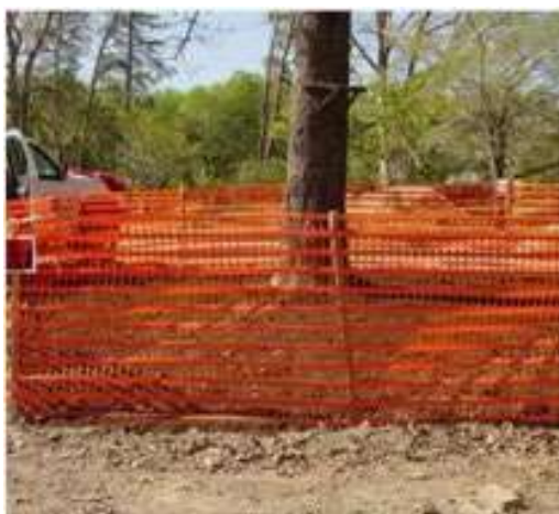
1.2.1 pav. Medžio apsaugos zonos aptvėrimas.
